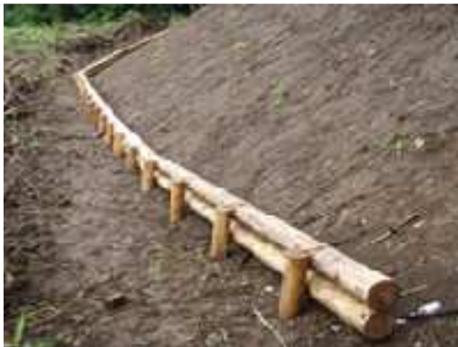
利用事例(簡易丸太柵工：土留め)
