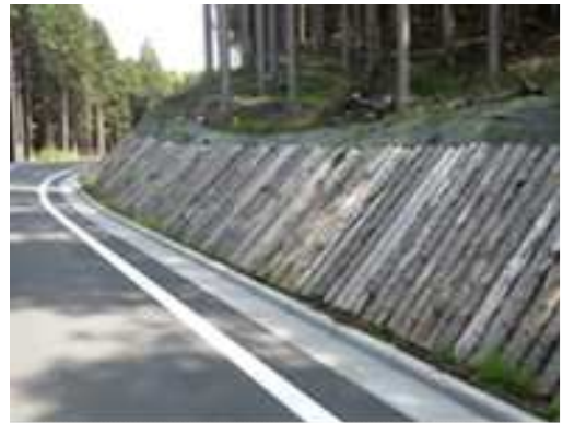
利用事例(丸太伏工：現場発生材利用)
