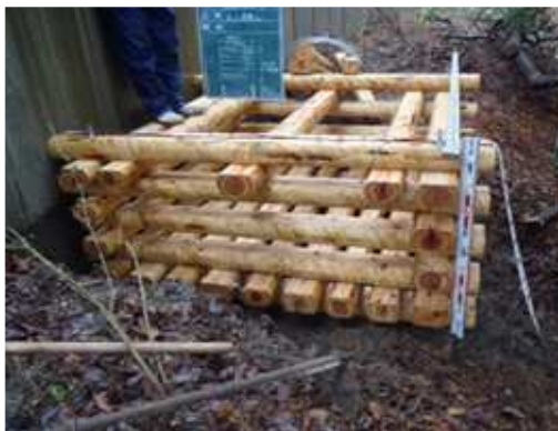
利用事例(木製沈床工)
